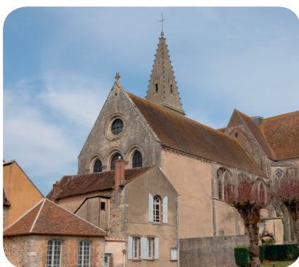
ÉGLISE ABBATIALE SAINT-PIERRE SAINT-PAUL FERRIÈRES-EN-GÂTINAIS
