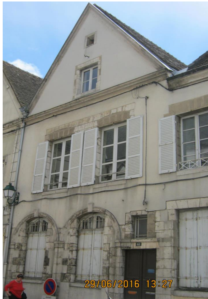
Façade côté rue
