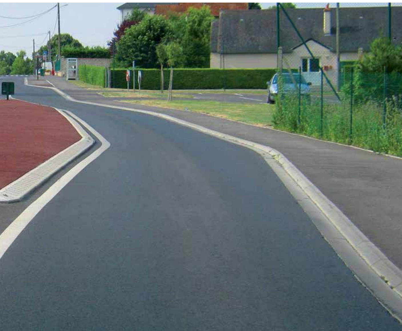
Source : Préfontaines – Entrée nord sur la RD40
