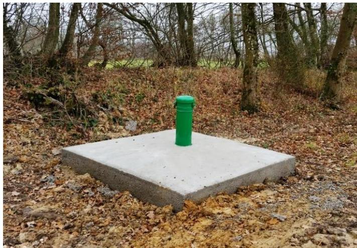
Figure 7 - Exemple de tête de forage (piézomètre), avec dalle de propreté réglementaire
