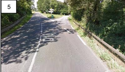
5 Intersection située dans une courbe hors agglomération dans une zone à 70 km/h avec panneau indicateur de vitesse. Profil en travers réduit au droit de l'étang. Route implantée sur la digue de l'étang avec dispositif de sécurité de part et d'autre de la chaussée. Réfection de la couche de roulement en juin 2018 sur les RD14 et RD13.
