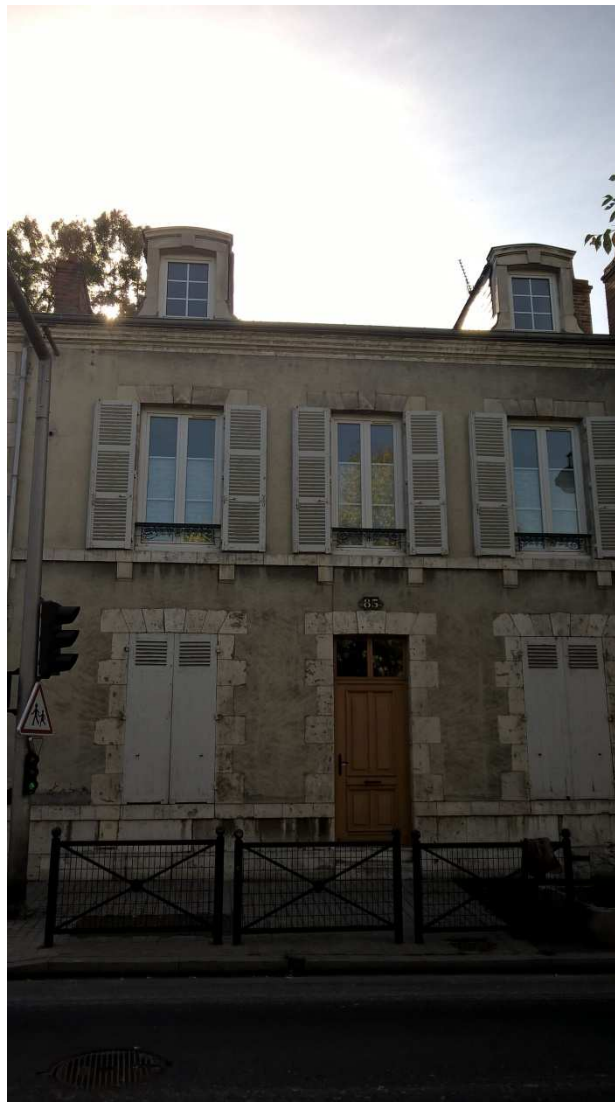
Façade côté rue
