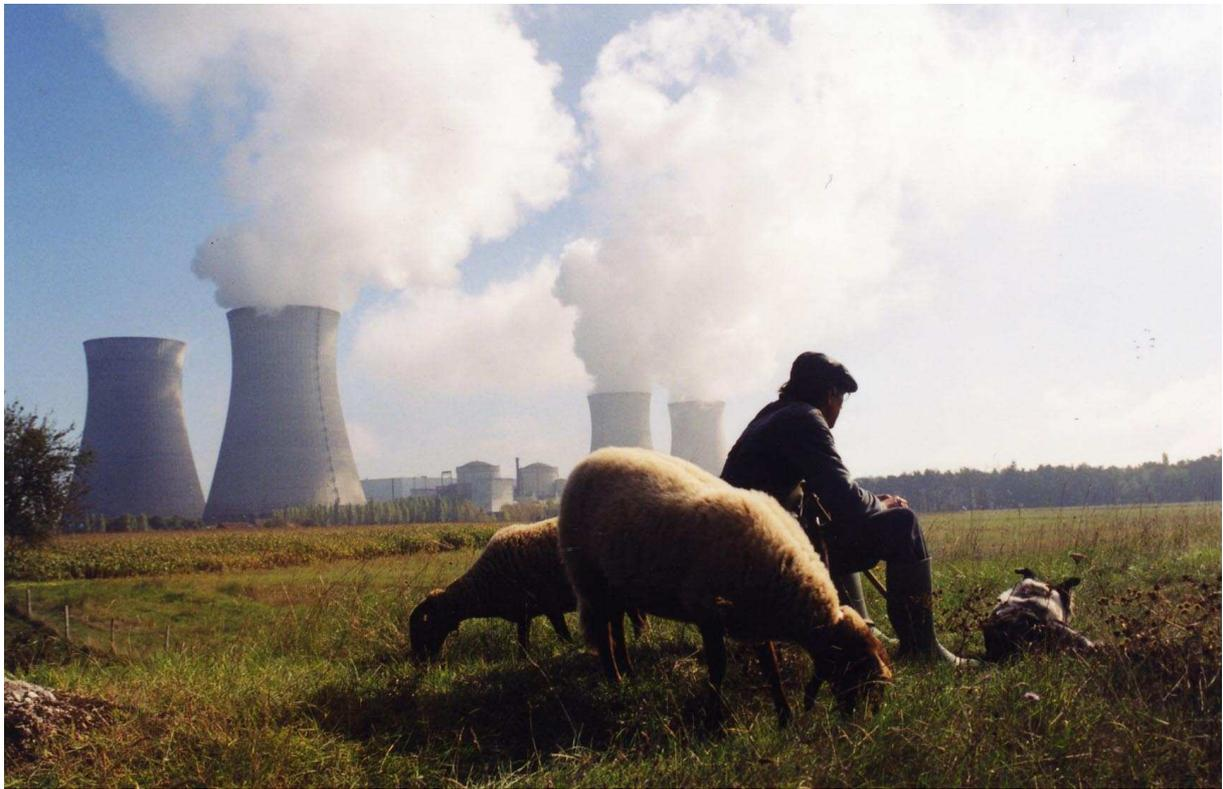
Les installations de Dampierre-en-Burly regroupent quatre unités de production d'électricité d'une puissance de 910 mégawatts chacune refroidies chacune par une tour aéroréfrigérante. Elles appartiennent à la filière à eau sous pression (REP).
