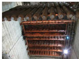
Fin du démantèlement des échangeurs CHINON A3 SUD
