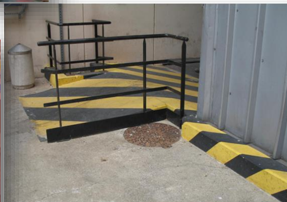
Seuil béton avec pente
