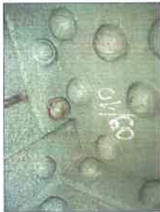
Photo n°14 : Fissure horizontale traversante sur l'âme du longeron G entre PP6 et PP7, sur ancienne réparation par soudure, longueur 150 mm (voir photo n°4).
