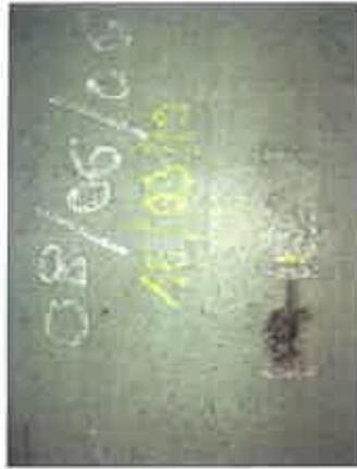
Photo n°3 : Fissure horizontale évolutive sur ancienne réparation par soudure, non traversante, sur l'âme de la pps (côté pp9), longueur 100 mm.
