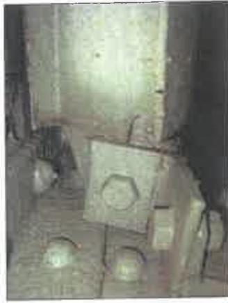
Photo n°23 : Entre sous platelage de rue côté droit déviation avec les 2 cornières de support cassées entre PP12 et PP13 (côté longeron gauche)
