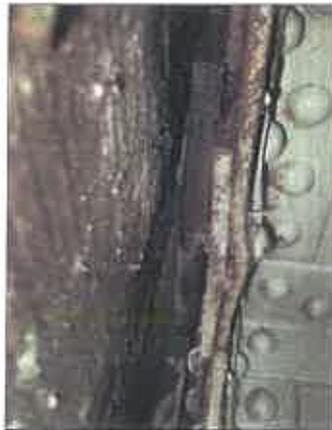
Photo n°18 : Déformation de la semelle inférieure de la poutre latérale D sur 720 mm de longueur entre PP3 et PP4
