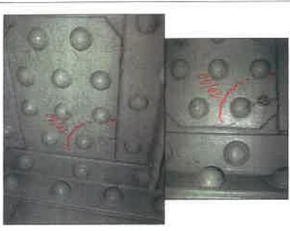
Photo n°36 : Réparation anciennes fissurées, non traversantes, sur l'âme de la PP26 côté D côté PP27.
