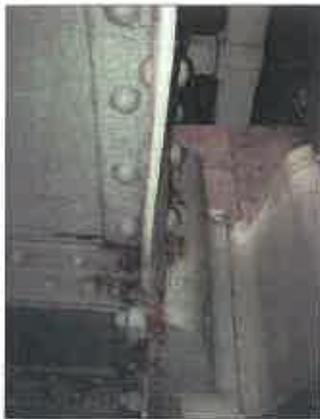
Photo n°2 : Fissure horizontale évolutive sur ancienne réparation par soudure, non traversante, sur l'âme de la pps (côté pp6), longueur 50 mm.
