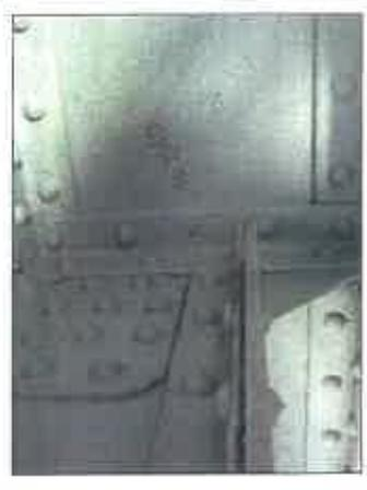
Photo n°33 : Angle du couvre joint fissuré de l'attache du longeron sur PP28 côté D.
