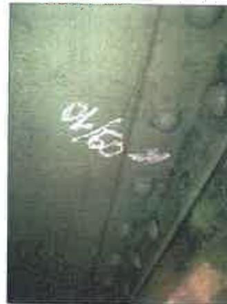
Photo n°13 : Un rivet loquant sur l'attache longeron D sur PP-15
