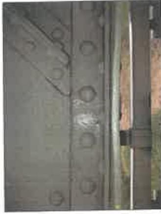
Photo n°25 : Fonctionnement de la sentelle inférieure de la poutre latérale D avant la zone d'appui sur pile 1.
