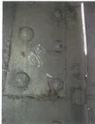
Photo n°20 : Une tête de rivet cassée au niveau du passage de contretraverse entre la poutre latérale E et la PP2
