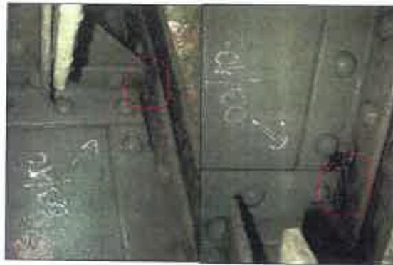
Photo n°12 : Manque une tête de rivet sur la semelle inférieure du longeron G entre PP-15 et PP-16.
