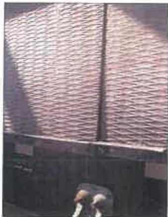
Photo n°82 : Pose d'un nouveau caillachot galvanisé côté gauche (janvier 2015).
