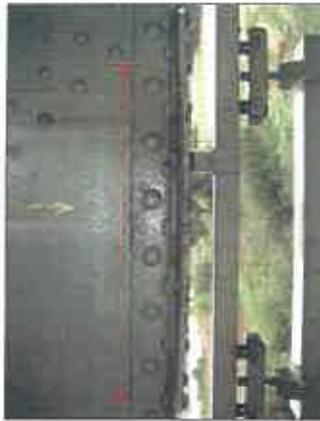
Photo n°19 : Plat additionnel de la semelle inférieure de la poutre latérale G soudé entre PP4 et PP2.
