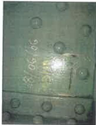
Photo n°11 : Manque 2 têtes de rivets sur la membrure inférieure de PP16 au droit des longerons (généralité sur l'ensemble des pièces de pont).
