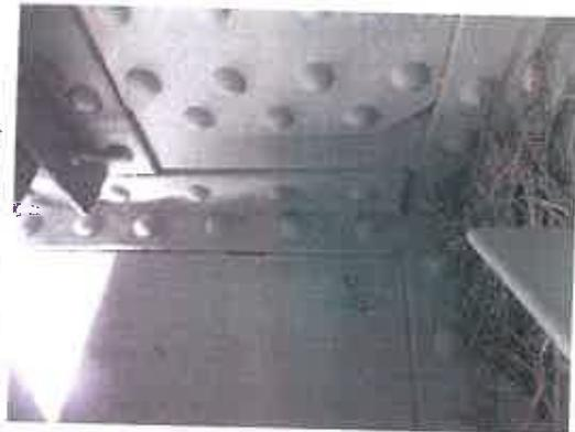
Photo n°101 : Consolidation d'eau potable. Une fuite d'eau est relevée entre P1 et P2 (208 mm de P1)
