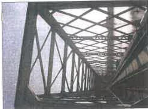
Photo n°86 : 2 lisses déformées côté extrémité côté droit.
