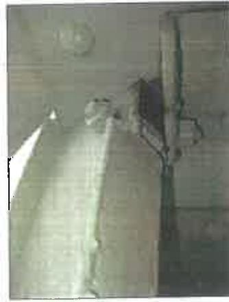
Photo n°24 : Déformation de la semelle inférieure de la poutre latérale D avant la zone d'appui sur pile 1
