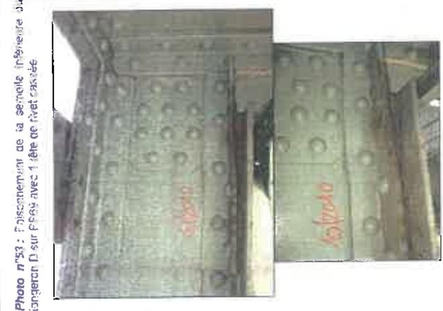
Photo n°53: Falschement de la section inférieure du longeron D sur PPS4 avec 1 tête de rivet cassée
