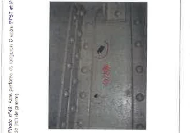
Photo n°49: Aile perforée du longeron D entre PPS7 et PPS58 (trot de guerre)
