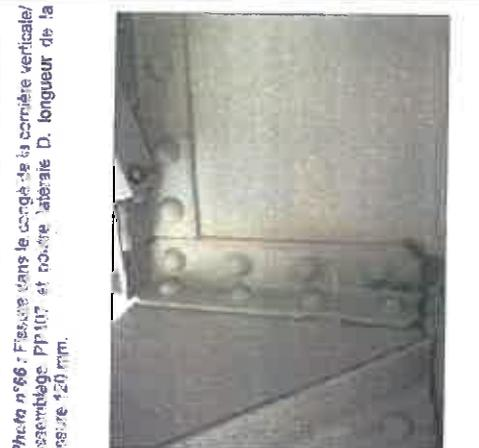
Photo n°66 : Fissure dans le congé de la cornière verticale/ assemblage PP107 et poutre latérale D, longueur de la fissure 220 mm.
