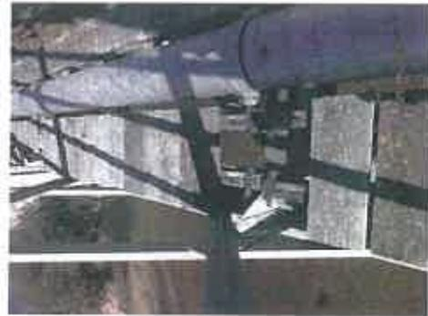
Photo n°85 : Cadre-corps côté droit. Manque une lisse intermédiaire.
