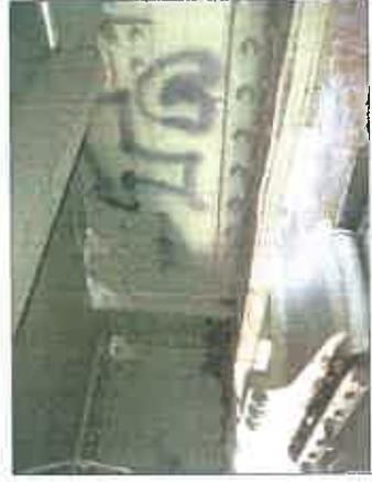
Photo n°32 : Manque une entraitise sous platelage de rive côté D entre PP36 et PP32.
