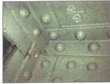
Photo n°7 : Une fissure dans le capot de la cornière du treillis gauche entre pp9 et pp10
