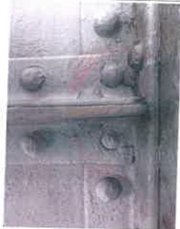
Photo n°99 : Révélation d'une fissure dans le congé de la cornière verticale de l'attache du longeron sur la pièce de pont 43 (côté 50) file droite.
