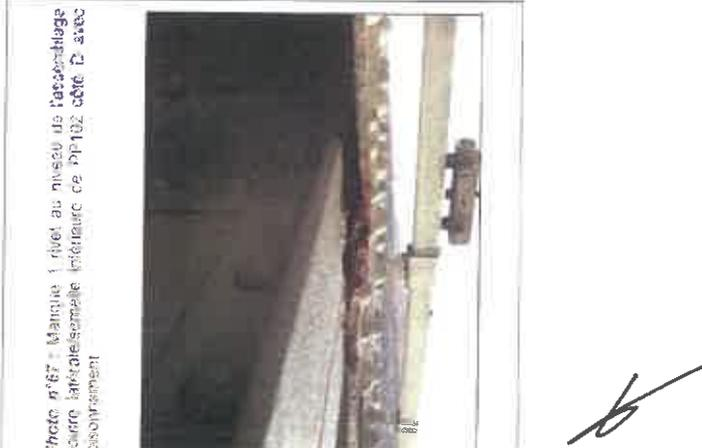
Photo n°67 : Manque 1 rivet au niveau de l'assemblage poutre latérale/longeron inférieur de PP102 côté D avec évidement
