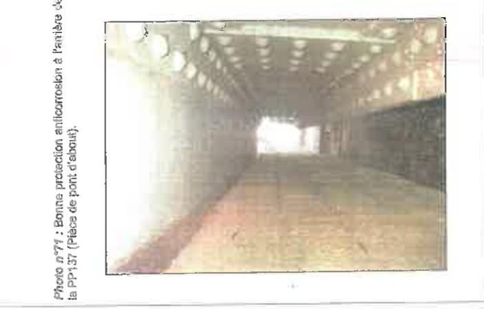
Photo n°71 : Bonne protection anticorrosion à l'arrière de la PP137 (Placa de pont d'about).
