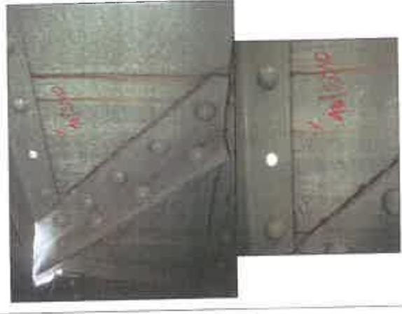
Photo n°37 : Fissure dans le congé de la cornière verticale de l'attache de la PP22 sur la poutre latérale D.
