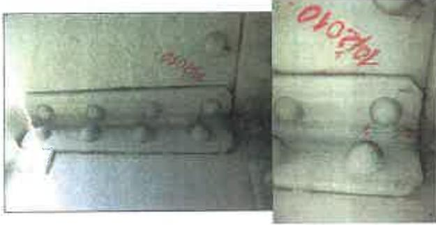
Photo n°31 : Déformation de la sentelle additionnelle inférieure côté D entre PP38 et PP35.
