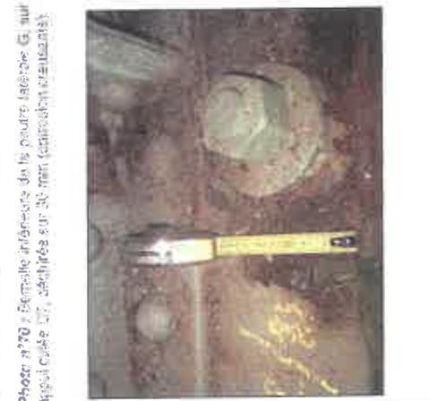
Photo n°70 : Serrille inférieure de la poutre latérale G sur appui cuée C7, sectionnés sur 30 mm (serrille éventuellement creusante)
