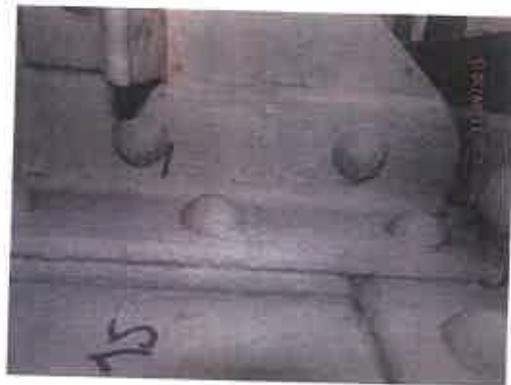
Photo n°100 : Révélation d'une fissure dans le congé de la cornière verticale de l'attache de la pièce de pont sur la poutre latérale à treillis (P142 côté droit).
