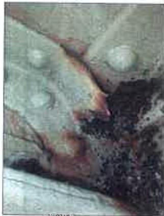
Photo n°10 : Une fissure non évolutive sur l'âme de la poutre gauche (au droit de PP-15).
