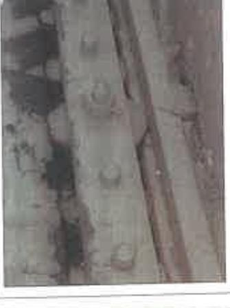
Photo n°39 : Appui mobile P3 D, platine inférieure fissurée
