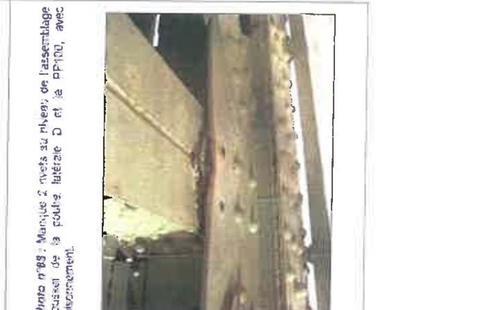
Photo n°68 : Manque 2 rivets au niveau de l'assemblage poutre de la poutre latérale D et la PP100, avec évidement.
