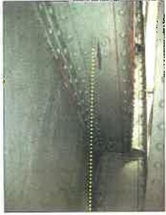
Photo n°38 : Area de la poutre latérale fissurée côté D entre PP21 et PP22, avec déconsolidation de l'attache de la cornière sous plâtrage. Manque un rivet
