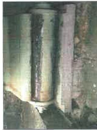
Photo n°16 : Appui CO droit - Semble fonctionné.
