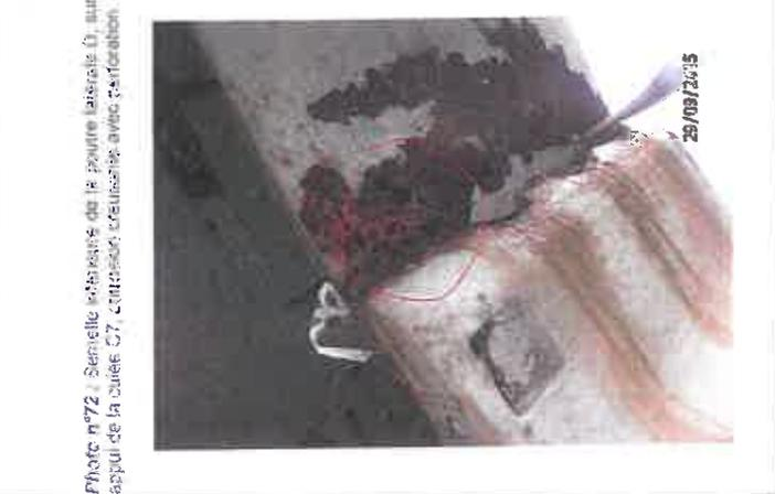
Photo n°72 : Serrille inférieure de la poutre latérale G sur appui de la cuée C7, sectionnée creusante avec perforation.
