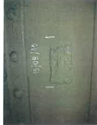
Photo n°9 : Corrosion foisonnante et creusante jusqu'à perforation de la cornière d'angle du renfort vertical du treillis G au droit de la PP-13.
