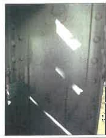
Photo n°35 : Fissure traversante sur réparation ancienne de l'âme du longeron entre PP25 et PP27 côté D.
