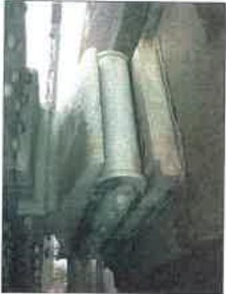
Photo n°27 : Appareil d'appui P1 gauche : fluege des plaques de plomb.
