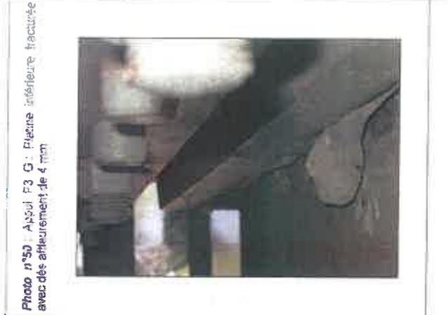
Photo n°50: Appui P3 G: Plaque inférieure fracturée avec des affaiblissements de 4 mm
