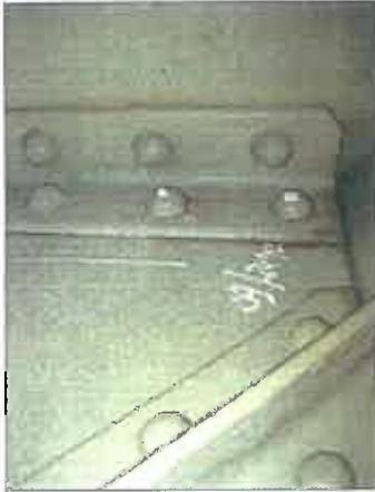
Photo n°8 : Une tête de rivet cassée sur longueur G entre pp12 et pp13 (sous plaquage)
