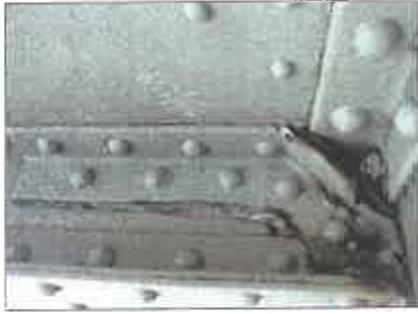
Photo n°5 : 2 rivets luxurians sur cornière verticale de l'arête de la pp7 sur la poutre latérale G
