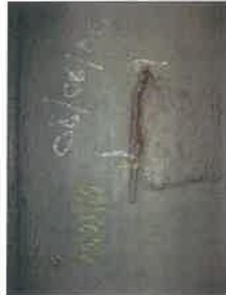
Photo n°4 : Fissure horizontale traversante sur lame du longeron G entre pp5 et pp7, sur ancienne réparation par soudure, longueur 140 mm (voir photo n°14)
