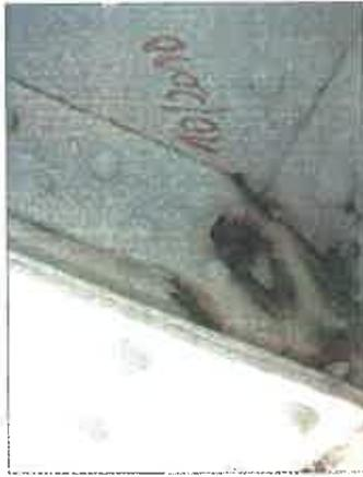
Photo n°30 : Fissure dans le cône de la cornière verticale d'attache de la PP35 sur la poutre latérale gauche.
