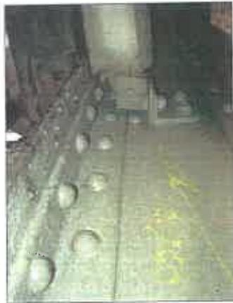
Photo n°22 : Entre sous platelage de rue côté droit déviation avec les 2 cornières de support cassées entre PP12 et PP13
