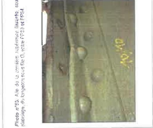
Photo n°55: Aile de la dernière section fissurée sous l'attelage du longeron sous file G, cote PPS3 et PPS4
