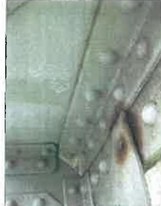
Photo n°21 : Entre sous platelage de rue côté droit déviation avec les 2 cornières de support cassées entre PP12 et PP13 (côté longeron droit)
