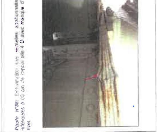
Photo n°56: Déformation des sections additionnelles inférieures à 50 cm de l'appui pile 4 (avec manque d'1 rivet)
