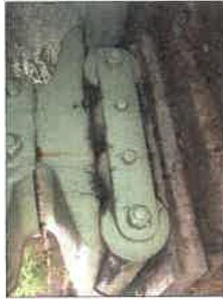
Photo n°17 : Les traverses entre PP1 et PP2 ne sont pas en appui. Déformation de la semelle supérieure du longeron droit.
