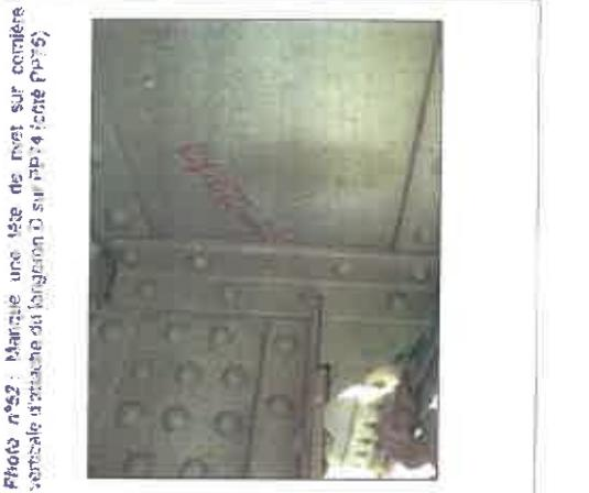
Photo n°52: Manque une tête de rivet sur cote verticale d'attache du longeron D sur PPS4 (cote PPS5)
