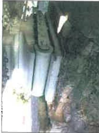
Photo n°29 : Corrosion creusante jusqu'à perforation de la tôle au droit du renfort vertical du treillis D au droit de la poutre PP32.
