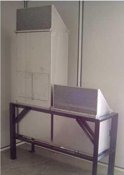
Recombineur d'hydrogène passif, afin d'éviter des explosions d'hydrogène dans le bâtiment réacteur
