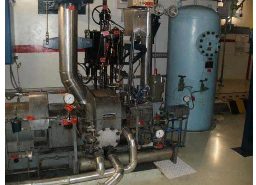
Générateur électrique autonome alimenté par la vapeur de la centrale
