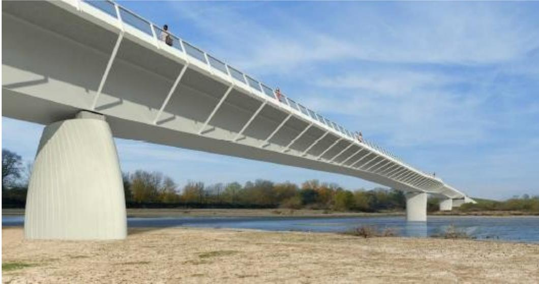
Les piles seront en béton d'une forme élancée avec recherche de transparence. L'ouvrage de franchissement étant en biais, au fur et à mesure que les piles sont au-dessus de l'eau, l'axe pivote pour se retrouver perpendiculaire au tablier. Ainsi les piles présentent une rotation de 27° entre la base et la tête, ce qui permet de les orienter suivant le sens d'écoulement de la Loire, avec un minimum de ralentissement du courant, tout en gardant l'ouvrage droit pour le tablier.
