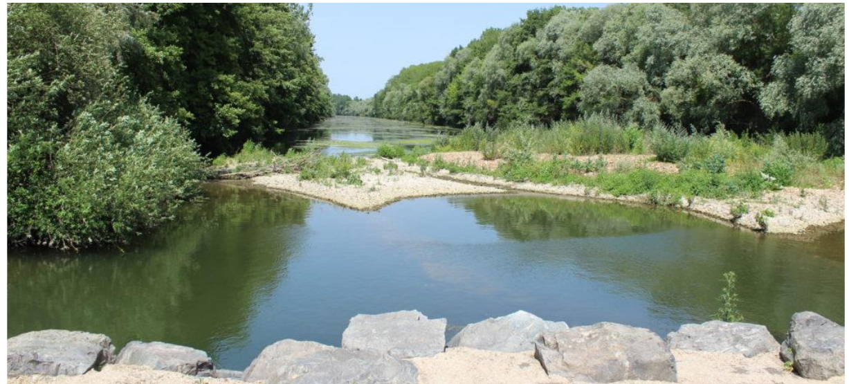
Figure 8 - Photo des rives du Loing aux abords de Cepoy
