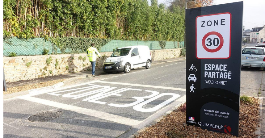
Figure 45: aménagement d'entrée de zone 30, Quimperlé,
