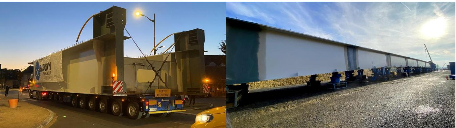
Début mars, la 1<sup>ère</sup> phase exceptionnelle de lancement a eu lieu, opération durant laquelle la première partie de la charpente métallique du pont est poussée sur la Loire. Le tablier, d'une longueur totale de 570 m, sera lancé en 3 fois, entre mars et septembre 2023, afin que les 2 rives soient totalement reliées.
