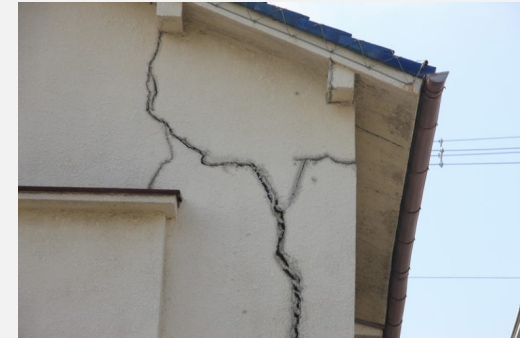
Dommages induits par le phénomène de retrait- gonflement des argiles
