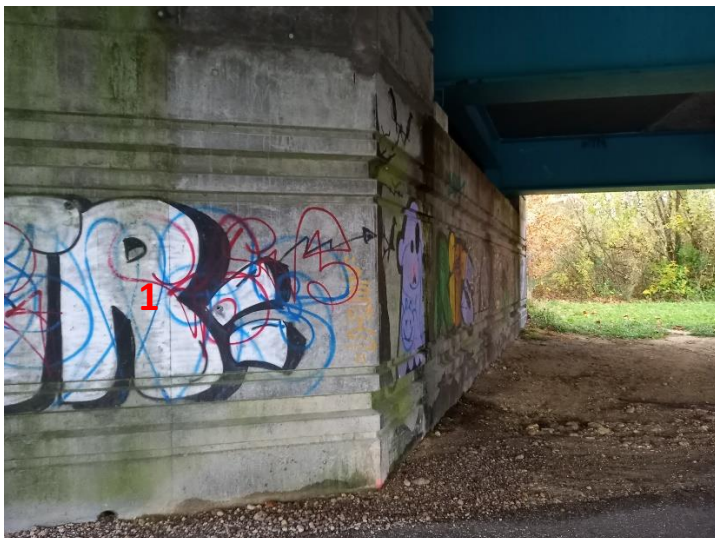
Colonnes d'appui dans le canal (2) :
