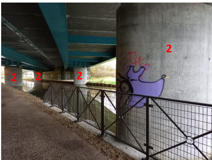
Paroi latérale à droite de l'ouvrage (3) :
