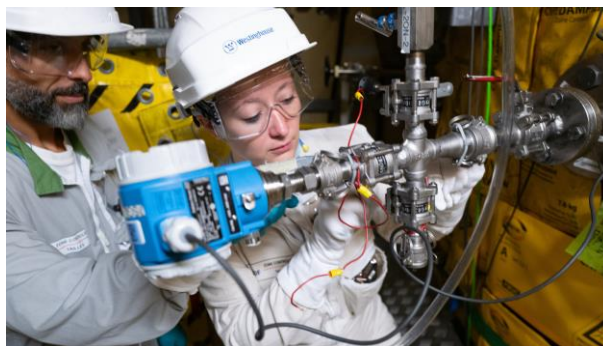
Nettoyage préventif des générateurs de vapeur. But : limiter l'encrassement prématuré des générateurs de vapeur et éviter les phénomènes de colmatage.
