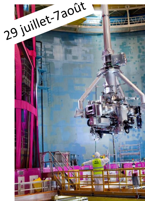
Contrôle de la solidité et de l'étanchéité de la cuve du réacteur
