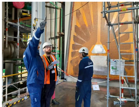
Retubage complet du condenseur Remplacement de 90 000 tubes. 160 personnes en 3*8 pendant 3 mois (GME Nuvia - Balcke Dürk Sous-traitants Plastocor- Orys-Actemium)
