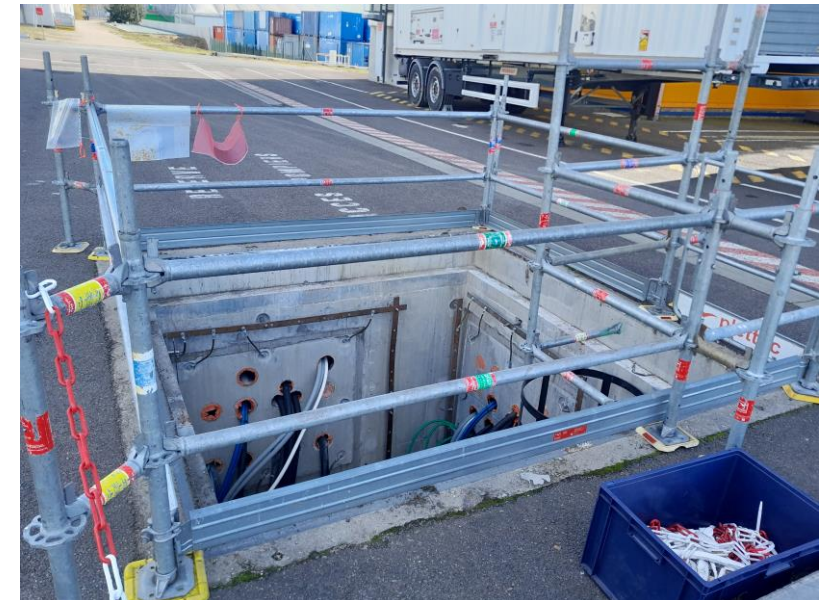
Préparation pour le passage de câbles d'alimentation de secours
