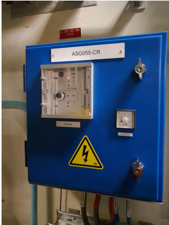
Mise en place d'un nouveau coffret
